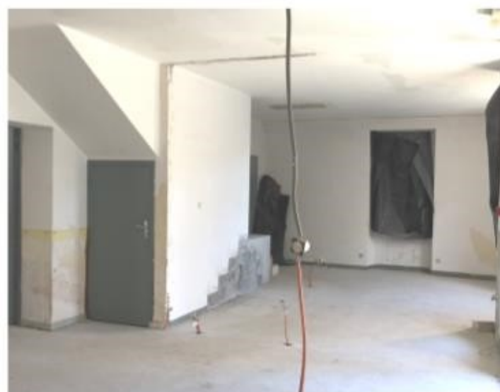
L'ancien accueil qui va être transformé en bureau
