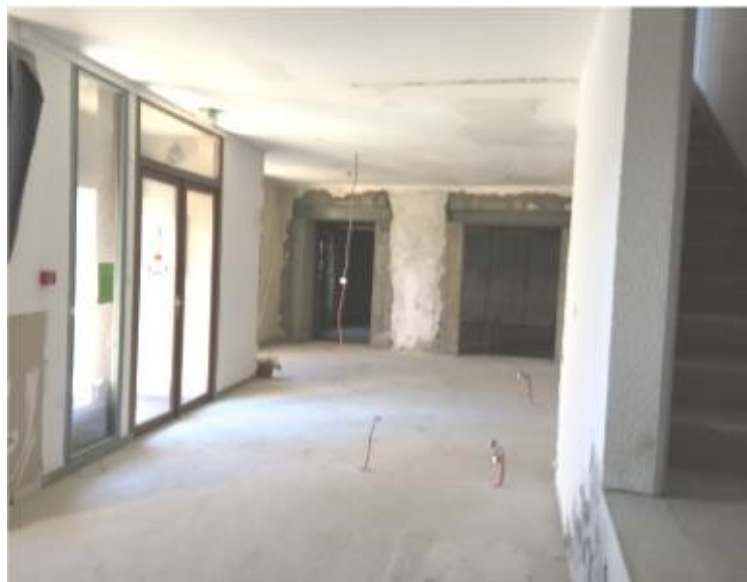
Vue sur l'espace qui accueillera le futur accueil du Secrétariat de mairie et de l'Agence Postale
