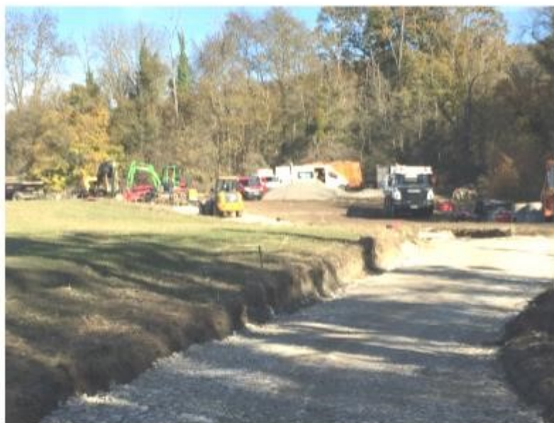
Terrassement du chemin
