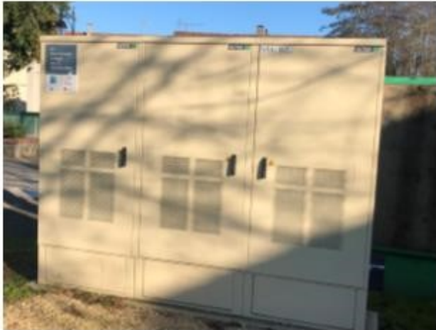
Armoire de montée en haut débit pour la liaison internet
