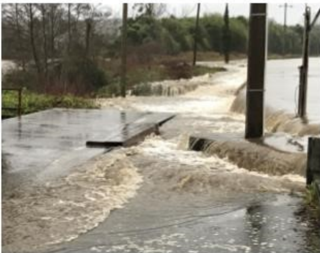
Le Salat au niveau de la centrale hydro-électrique
